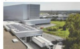
Im Werk erzeugt eine Photovoltaik-Anlage reichlich Strom. Alle Fotos: Marburger Tapetenfabrik
